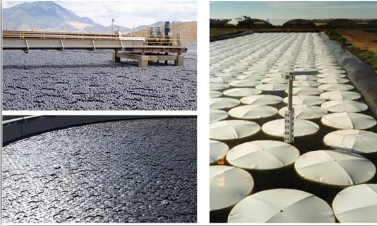
Şekil 8.1. (Solda) Su depolarından buharlaşmayı azaltan yüzer opak elemanlar: Yüzen toplar ve altıgen karolar; (sağda) yüzer diskler (Assouline & Narkis, 2021)
